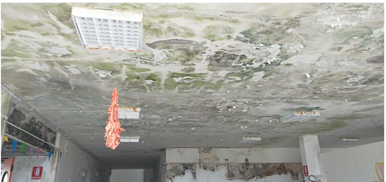
INFILTRAZIONE PER INTASAMENTO DISCENDENTI PLUVIALI
