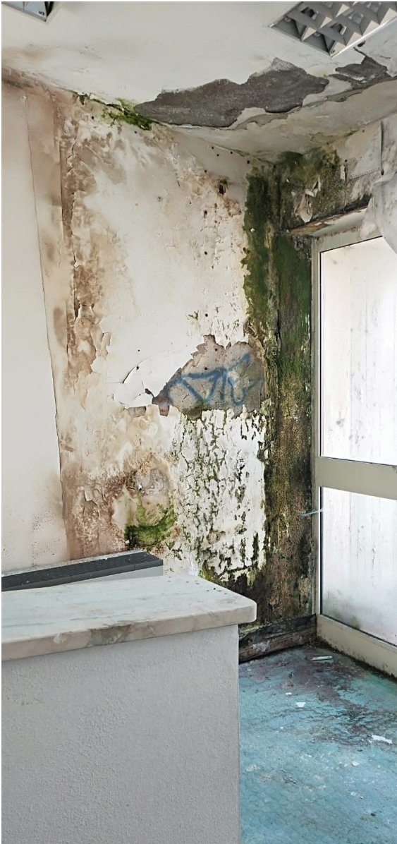
INFILTRAZIONE PER INTASAMENTO DISCENDENTI PLUVIALI
