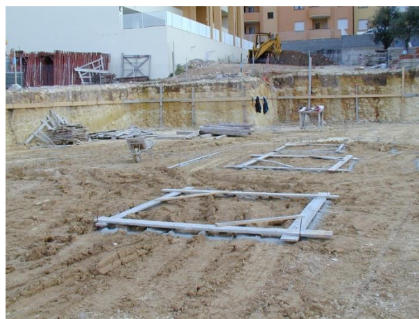
Foto 2 – Via Mastino - Veduta panoramica dello scavo per la preparazione del piano di fondazione del cantiere adiacente l'area d'intervento
