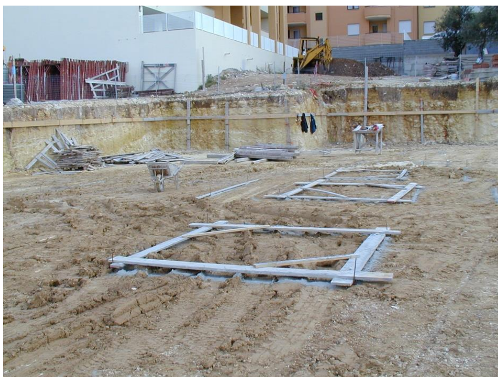
Foto 2 – Via Mastino - Veduta panoramica dello scavo per la preparazione del piano di fondazione del cantiere adiacente l'area d'intervento
