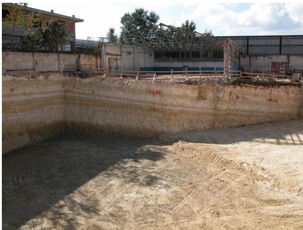
Foto 1 – Piazzale Segni - Veduta panoramica dello scavo per la preparazione del piano di fondazione
