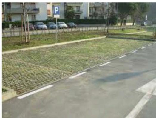
2) aree di sosta: saranno realizzate con **pavimentazioni permeabili "drenanti" in cls**, che permettano di ottenere un completo drenaggio delle acque meteoriche senza ristagni. Il particolare disegno dell'elemento in cls consente al manto erboso di svilupparsi in maniera uniforme fino a rivestire il 50% dello spazio ricoperto.
