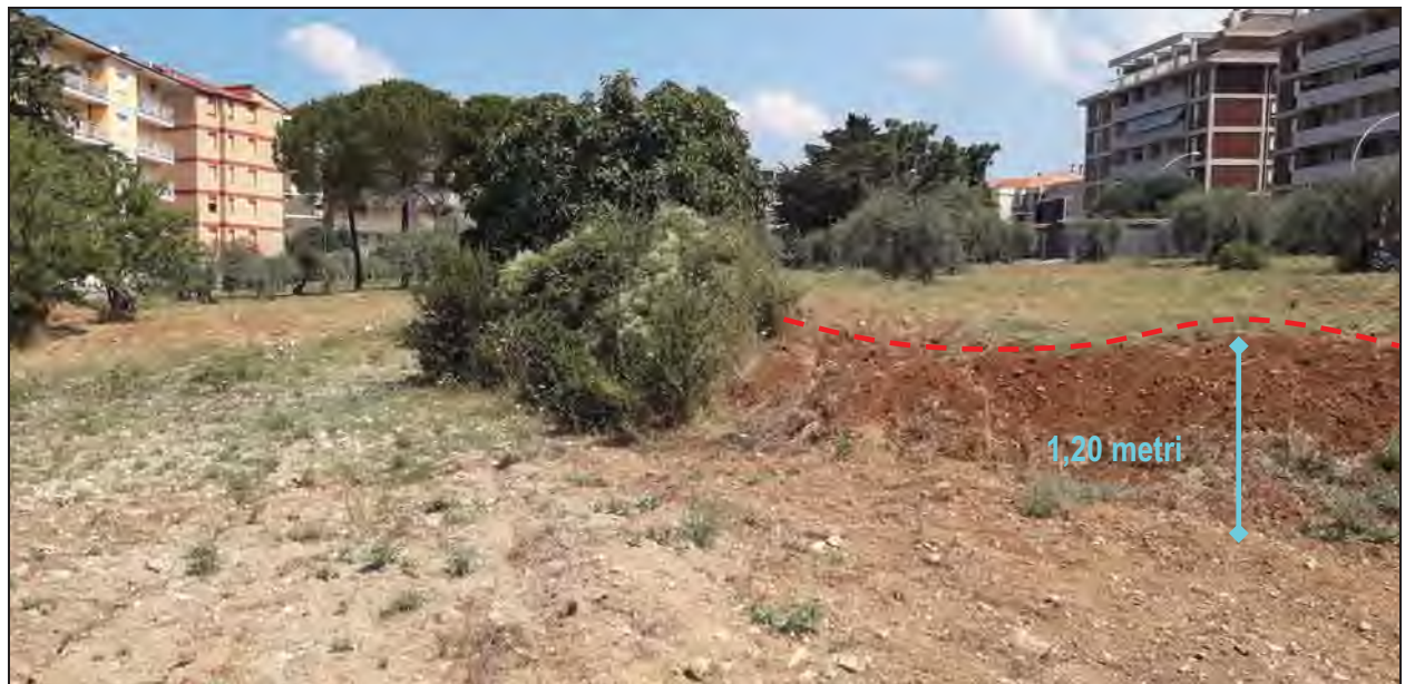
Figura 21. Scarpata artificiale modellata sulla coltre alteritica delle marni, vista da sud. L'altezza è inferiore a 1,50 metri.
