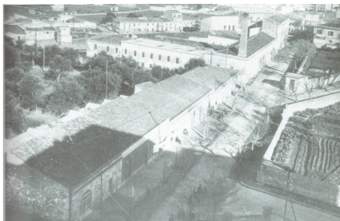
Figura 4 - Il retro dello stabilimento Dau, oggi demolito - sullo sfondo è via delle Conce
