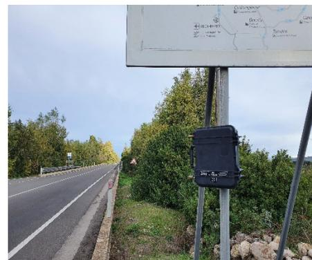
*Radar e Miovision utilizzati per il rilievo automatico dei flussi a Sassari*
