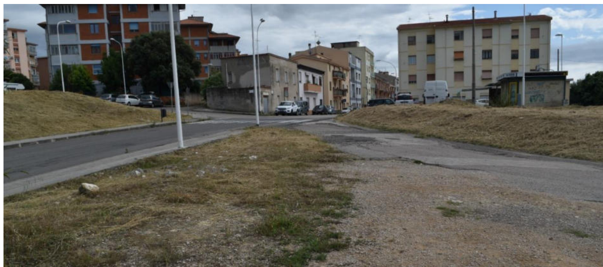
Figura 13 - Vista generale della Via Baldedda, all'attacco con Via Monte Furru, incrocio con Via Bonorva, con lo sterrato e parcheggio
