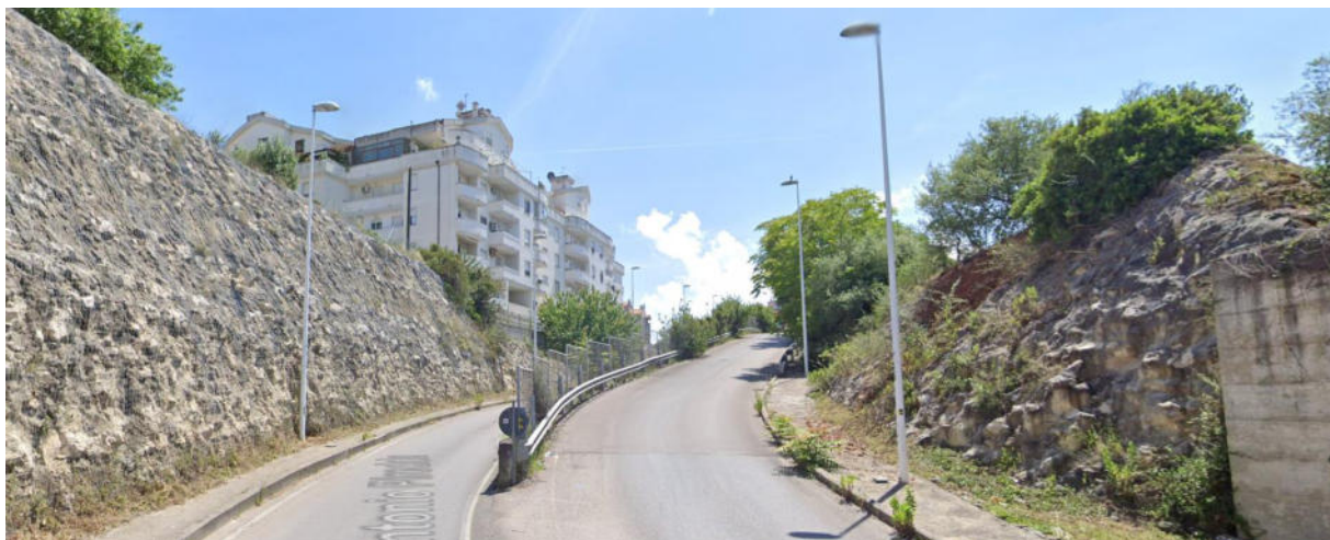
Figura 21 - Vista della Via A. Piredda in corrispondenza della biforcazione in due carreggiate a quote e sensi di marcia differenti
