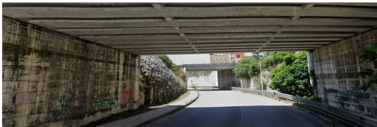
Figura 23 – Vista della Via A. Piredda in corrispondenza dei due sottopassaggi
