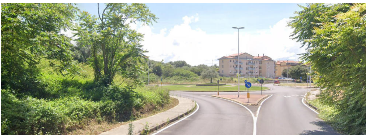
Figura 26 – Vista della rotonda all'incrocio tra Via R. Ruffilli, Via A. Piredda e Via Monte Furru dalla Via A. Piredda
